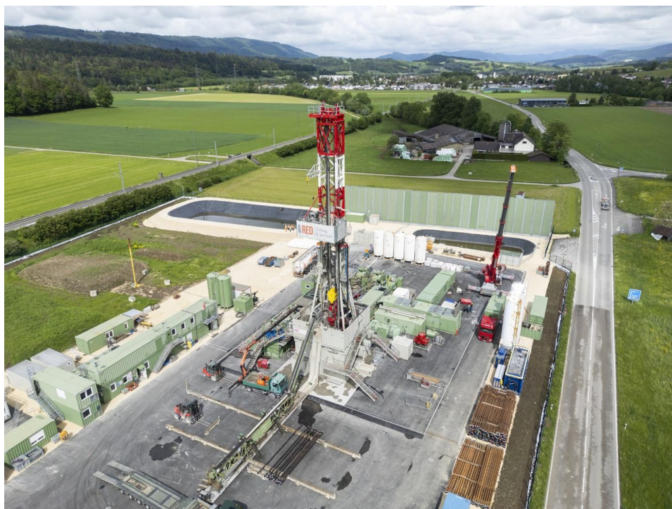
Chantier de Haute-Sorne en mai 2024
