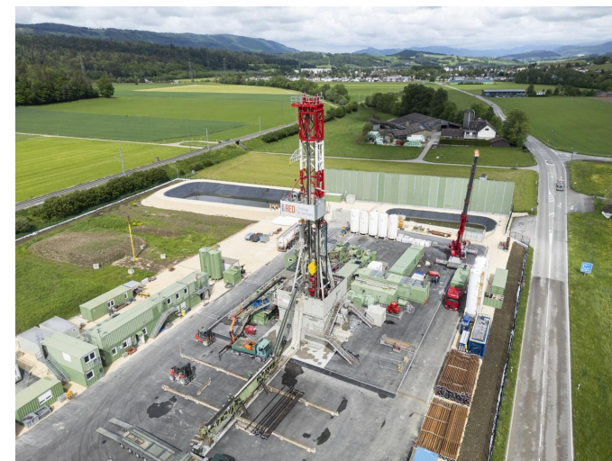
Chantier de Haute-Sorne en mai 2024
